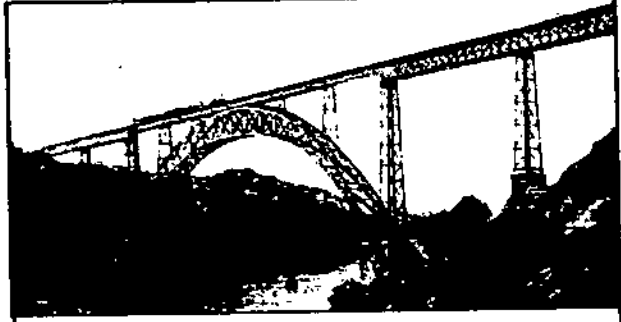
شكل (٢-١٢) جسر دورو (Douro) بجزره ١٦٠م، بناه غوستاف إيفل في ١٨٧٥م. المصدر (Giedion, 1978)
